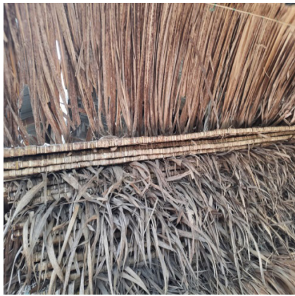
Gambar 2. Daun Tebu Kering sebagai Material Atap Rumah di Kampung Adat Keputihan (Sumber: Dok. Penelitian Ai Juju Rohaeni, dkk., 2024)
