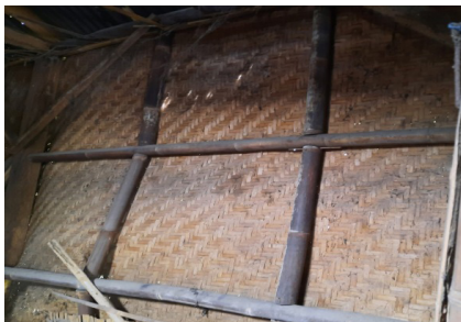
Gambar 3. Anyaman Bambu yang disebut bilik atau geribik (Sumber: Dok. Penelitian Ai Juju Rohaeni, dkk., 2024)
