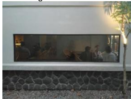
Gambar 30: Dinding Warna Putih (sumber: dokumentasi peneliti)
