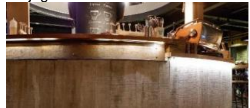
Gambar 29: Acian Halus Pada Counter (sumber: dokumentasi peneliti)
