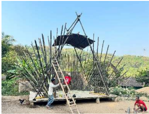
Gambar 11. Proses pembuatan panggung berbahan bambu (Dokumentasi : Rizky Mulyana, Agustus 2024)
