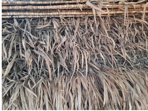
Gambar 4. Material Atap dari Daun Tebu Kering (Sumber: Dokumentasi Penelitian Nia Emilda, dkk., 2024)
