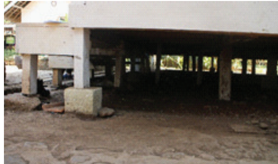
Gambar 6. Pondasi dan struktur rumah panggung Kampung Pulo (Sumber: Sriwardani, 2019)
