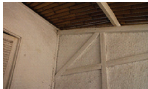
Gambar 10. Rangka bangunan rumah adat Kampung Pulo (Sumber: Sriwardani, 2019)
