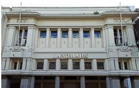
Gambar 8. Gedung Landmark (Dokumentasi: Ganesha Wibisana, 2020)
