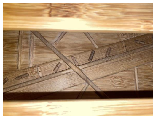
(Gambar 4. Tampak Tengah Bracing Kacapi indung Milik Pribadi)
